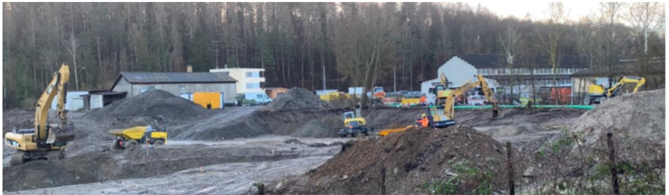
Aushub und Erdbewegungen auf dem zukünftigen Parkplatz anfangs 2021
